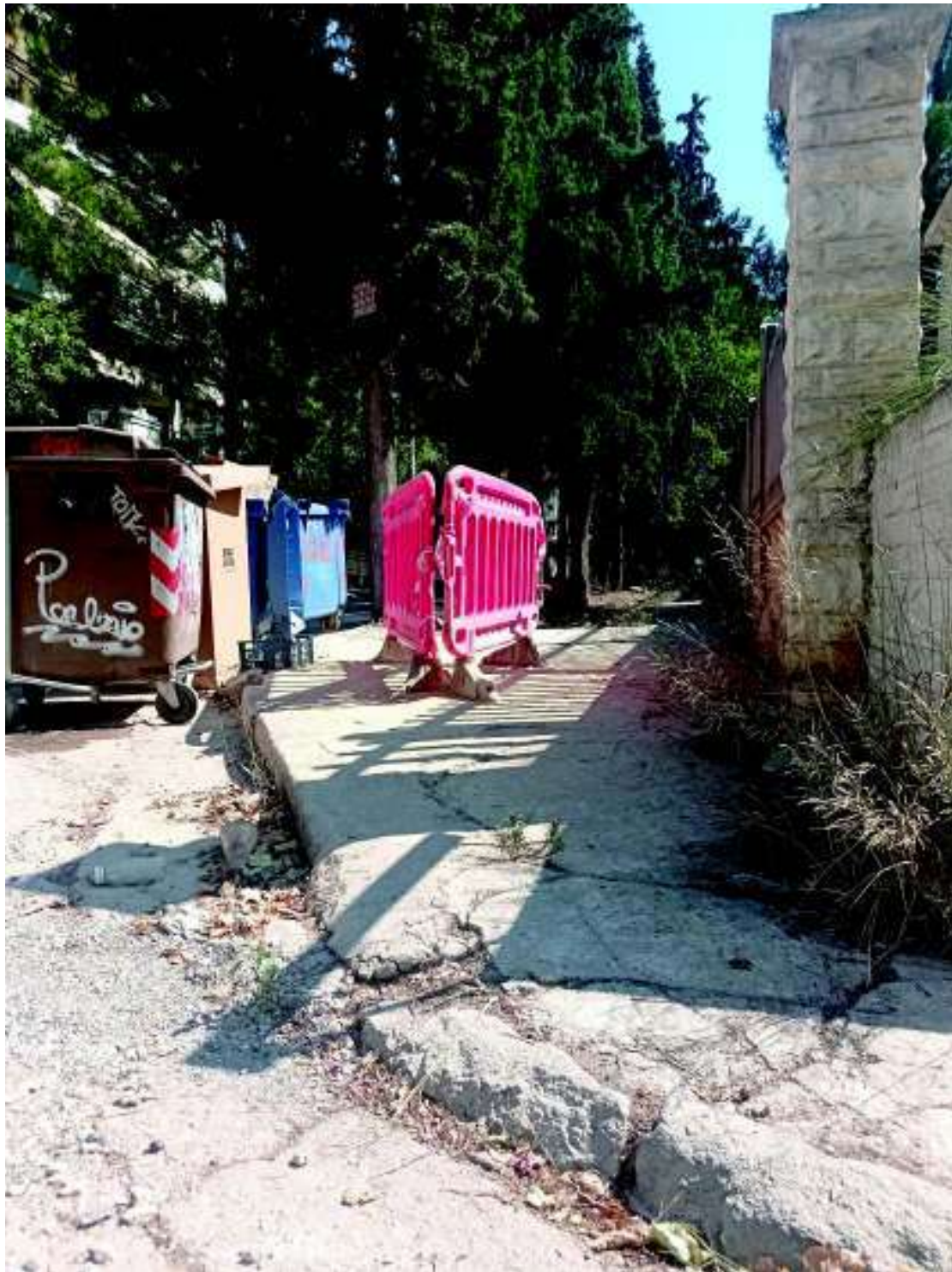
Εικόνα 52: Χώρος πρασίνου στο πεζοδρόμιο (οδ. Σπάρτης)
