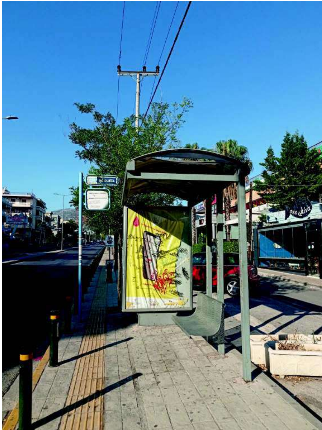
Εικόνα 171: Στάση Άνω Βριλήσσια
